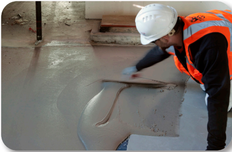
Fraguado rápido: se instala el piso en apenas 15 a 20 minutos
