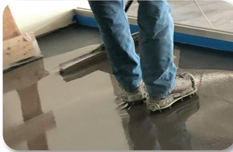
Superficie super lisa – no necesita lijado ni recubrimiento de enlucido
