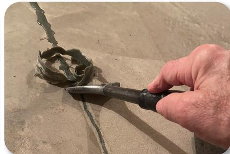
Sèche en moins de 60 minutes ce qui permet d'effectuer immédiatement l'installation sur le joint. Moins de temps pour installer le revêtement de plancher qu'une rustine
